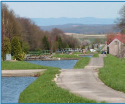
Echelle d'écluses entre Valdieu et Retzwiller
